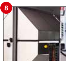
Gegenstromwärmtauschler
